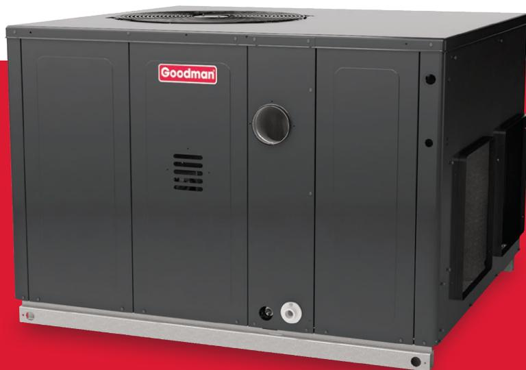
**1 Capacité de climatisation efficace** – La configuration du tube en cuivre de qualité supérieure de 5 millimètres et du serpentin du condenseur à ailettes en aluminium offre des propriétés de transfert de chaleur exceptionnelles (certains modèles).
